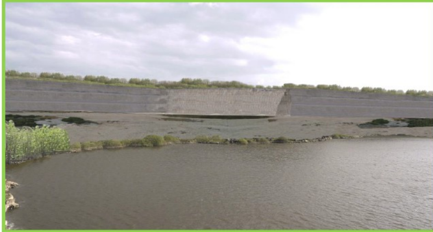
Vue des fronts de taille et de la plateforme laissée en libre évolution depuis le Nord de l'emprise
